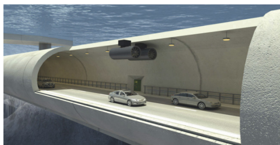
Figura 8C-2 Projeto de túnel/ponte flutuante na Noruega
