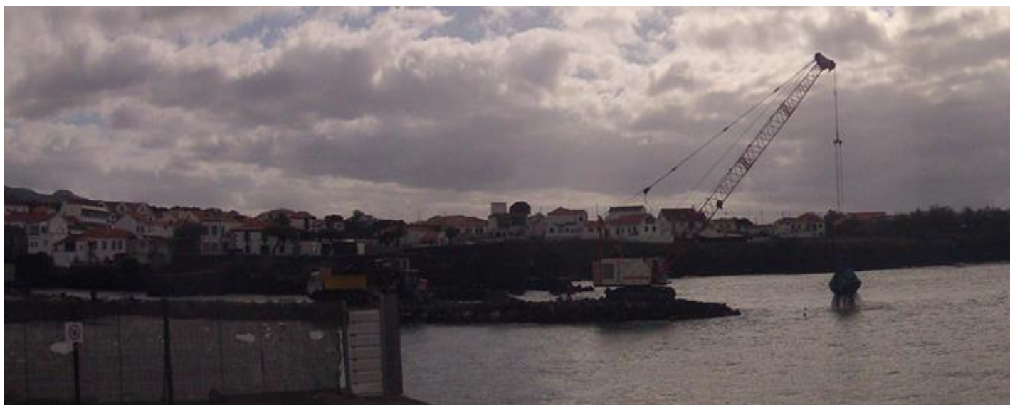
Figura III.2. 3 - Dragagem de inertes, em novembro 2012, para construção do contra molhe no porto da Madalena – Ilha do Pico, Açores. (Foto: Carlos J. Moura).
